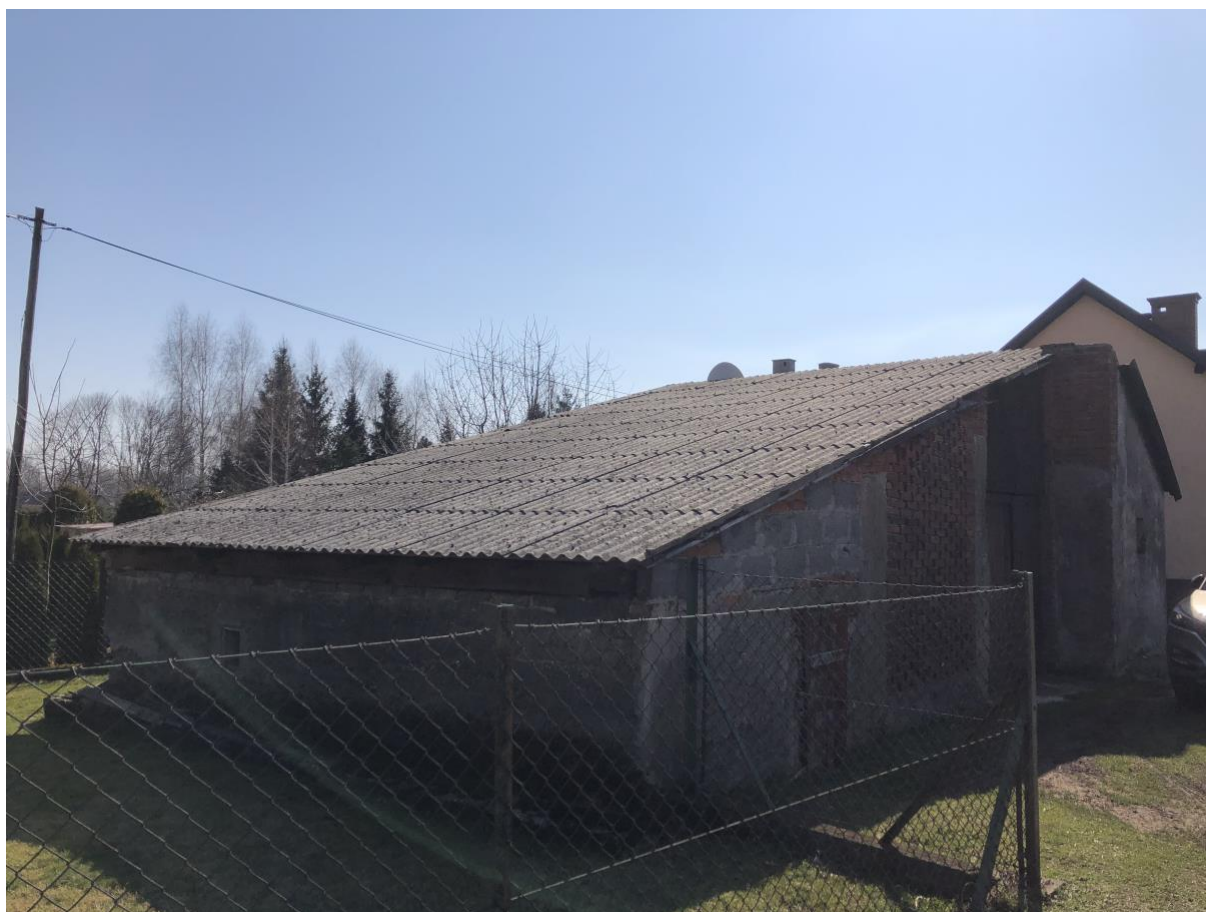
Rysunek 5 Dach budynku gospodarczego pokryty płytami azbestowymi falistymi (budynek przykładowy)
